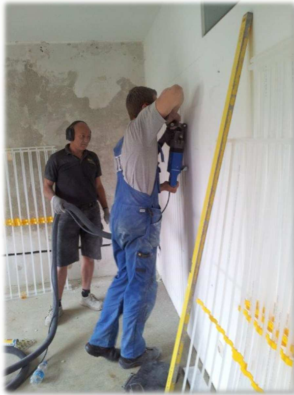
Bild 1: Arbeitsgang – Fräsen im Bestand
