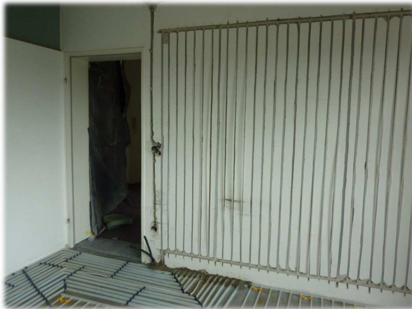
Bild 2: Fertig installierte Wandfläche in Kombination mit Fußbodenfläche im Bestand
